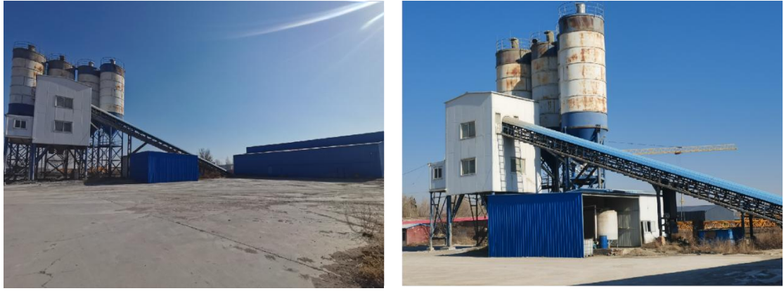
图 3-4 项目厂区现场照片
